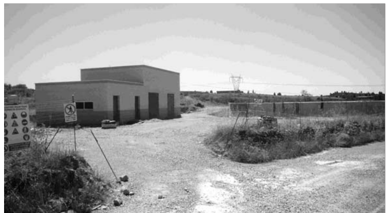
Estado actual de las obras
